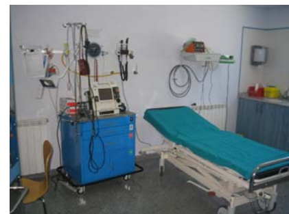
Nou box de reanimació a les noves instal·lacions d'Urgències
